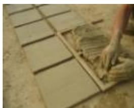
Figura 1. Construcción de ladrillos de barro.
