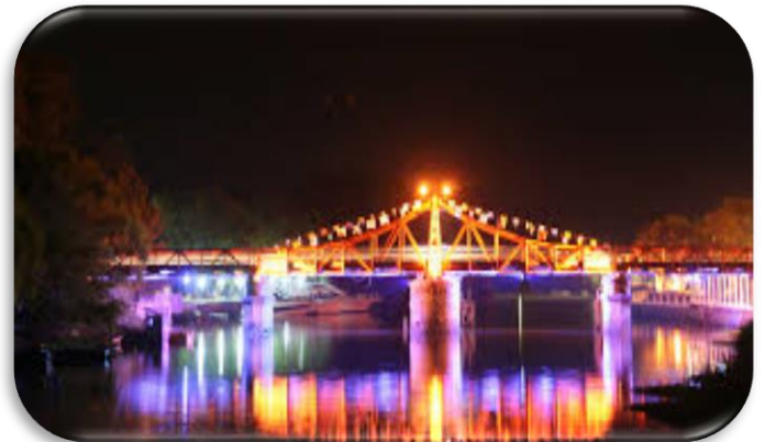
Puente de Laguna Garzón
